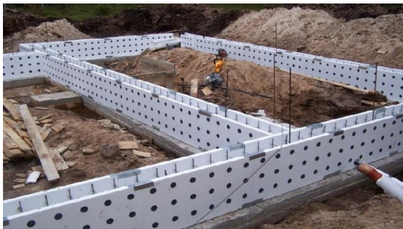
Рисунок 12 – Несъемная опалубка
