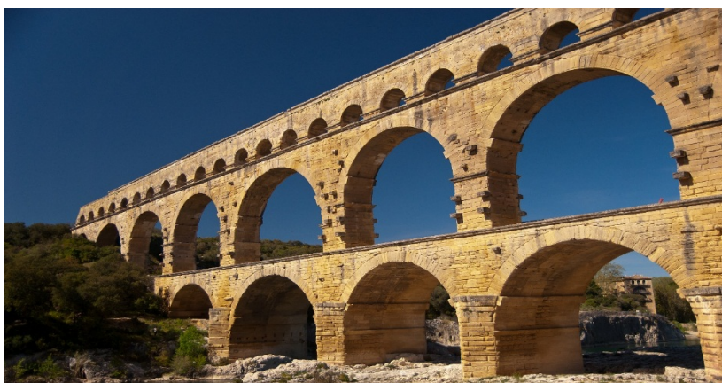
Рисунок 2 – Римский виадук из пуццолановского бетона
